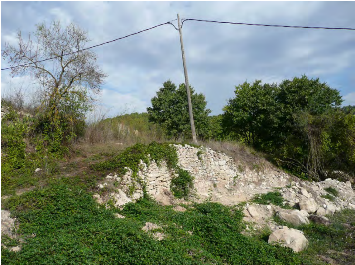
Vistes 7 i 8. En el costat oest hi ha restes d'un llarg mur que segurament tancava la part de parcel·la mes propera a l'edificació.
