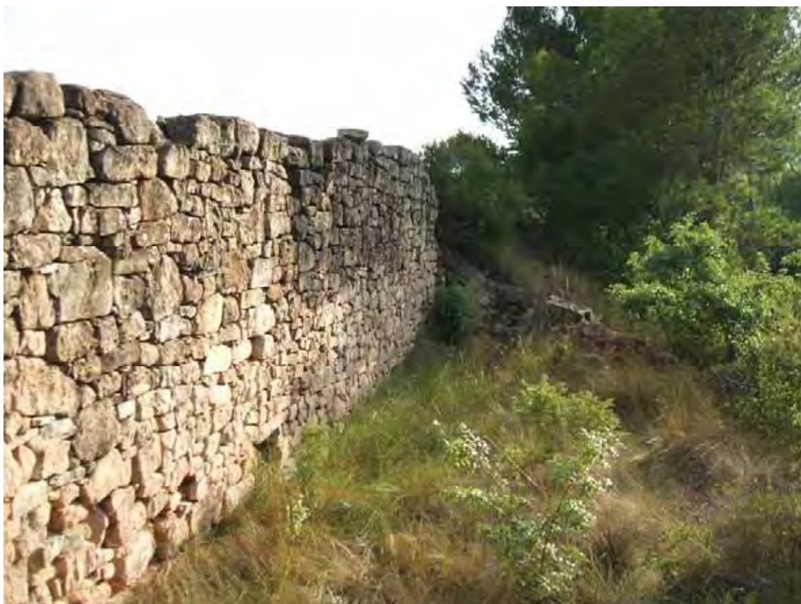
Façana Nord Oest – Àmbit Camí
