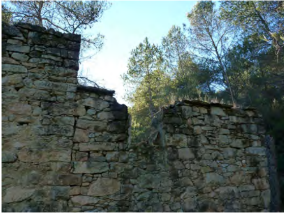
Els dos volums a diferent alçada i el petit ràfec d'arrencada de la coberta. El pendent de la coberta.
