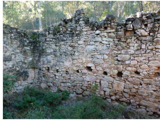
Els dos volums a diferent alçada i el petit ràfec d'arrencada de la coberta. El pendent de la coberta.
