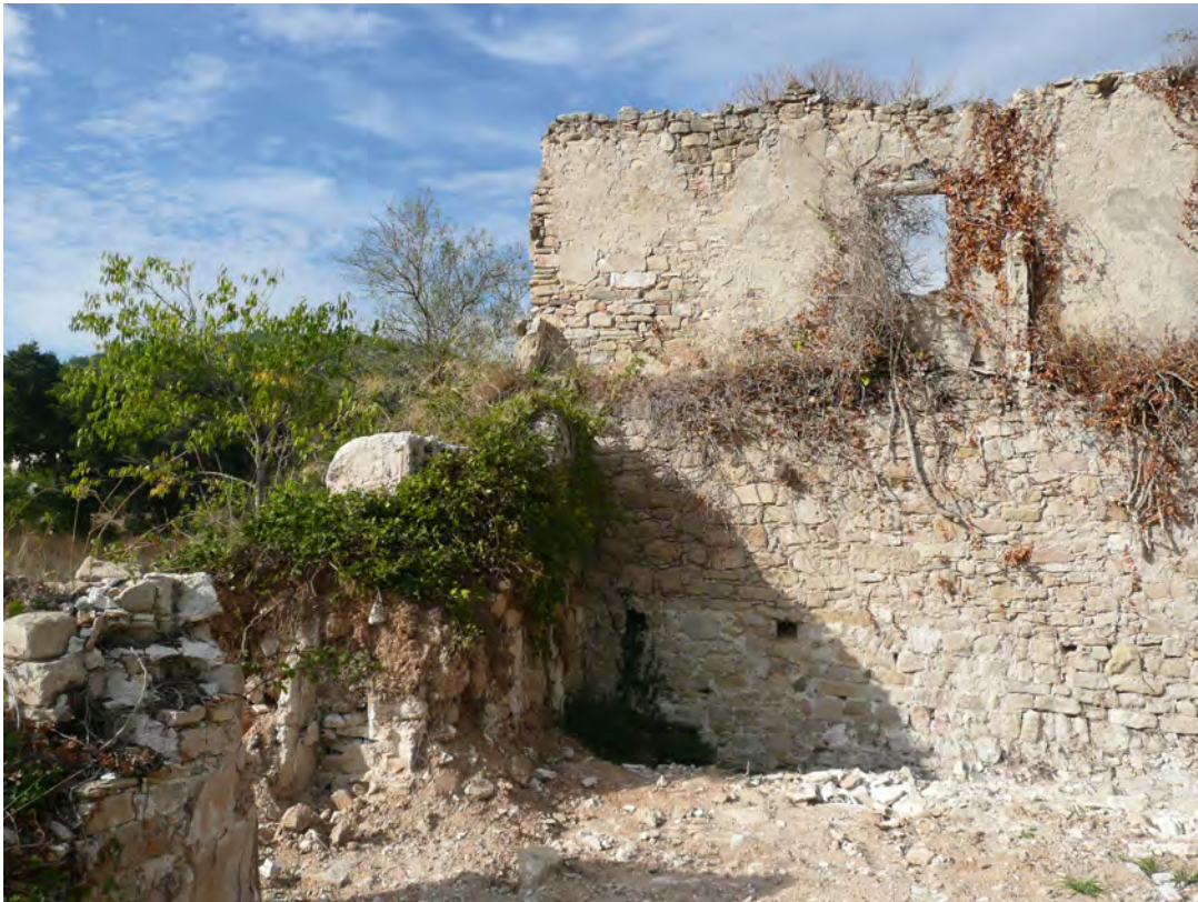
Vista 5. Façana sud, únicament restes de la façana en la cantonada amb la façana est. Es pot intuir que hi havia una entrada en aquest punt.
