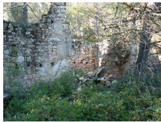
Els caps de les bigues en permeten veure el nivell on era el forjat
