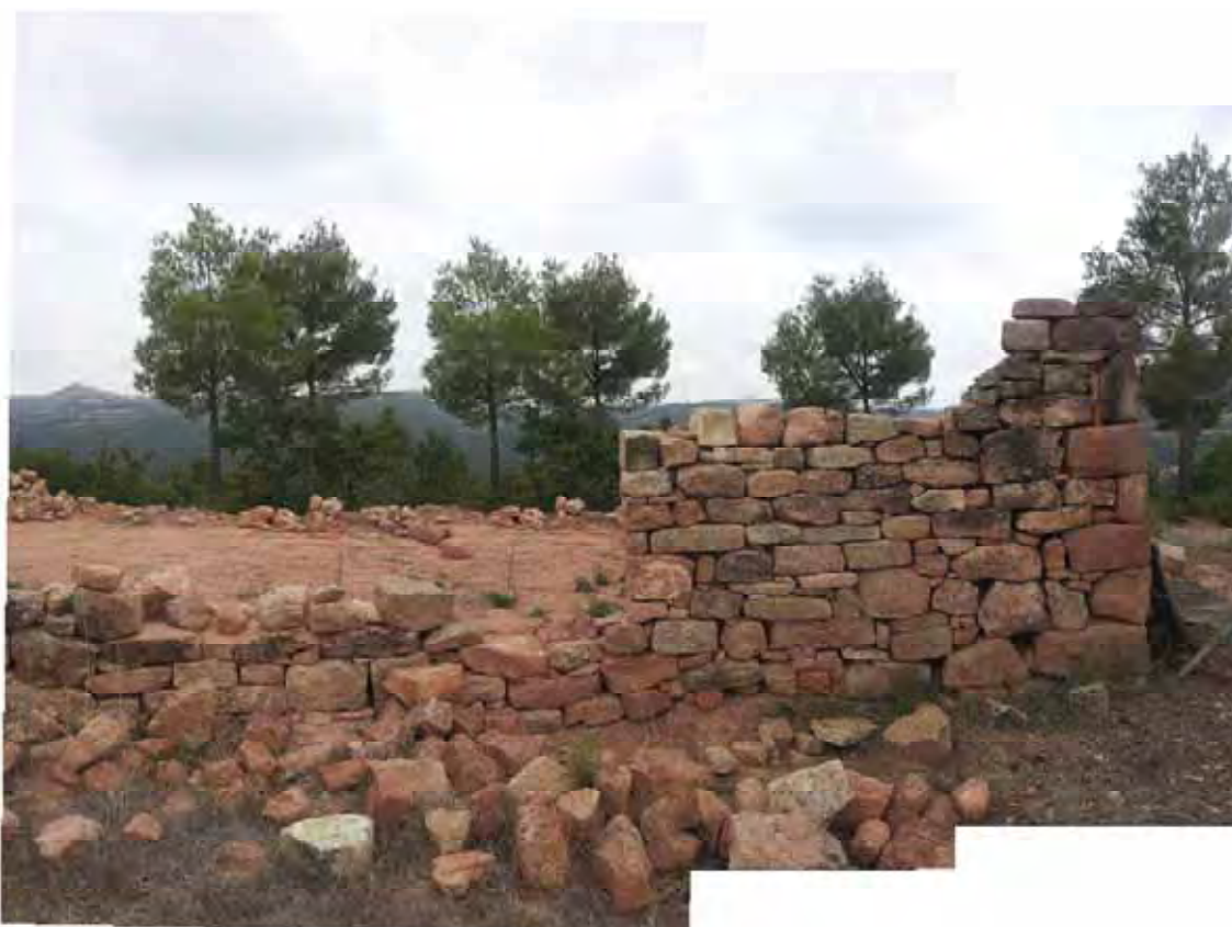
Façana Sud Est – Àmbit superior al camí cantona Nord Est
