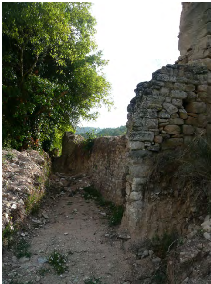
Vista 2. Façana nord, hi ha restes de certa entitat, però de forma discontinua.
