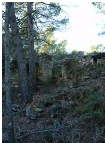
Un Accés a la construcció principal
