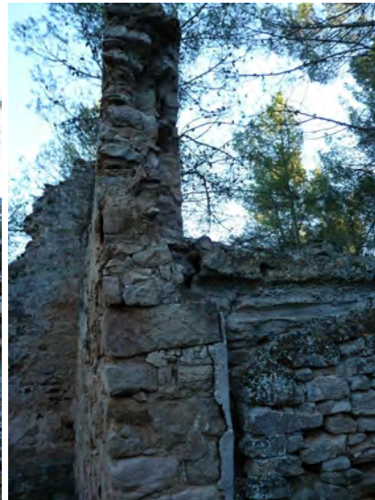
Diverses tipologies de mur. En algunes façanes es veu el acabat de morter de calç.
