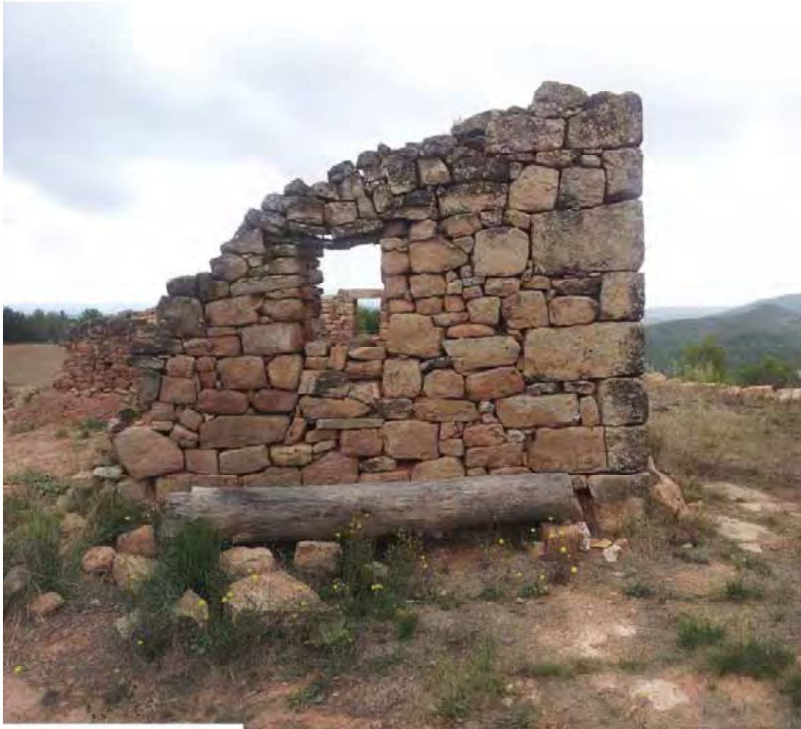
Façana Nord Oest – Àmbit superior al camí
