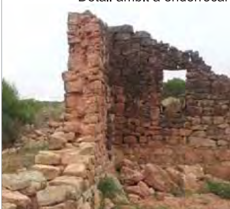
Detall tipologia de mur existent
