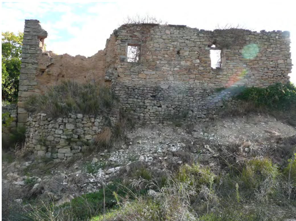
Vista 1. Façana oest, la de millor estat de conservació.
