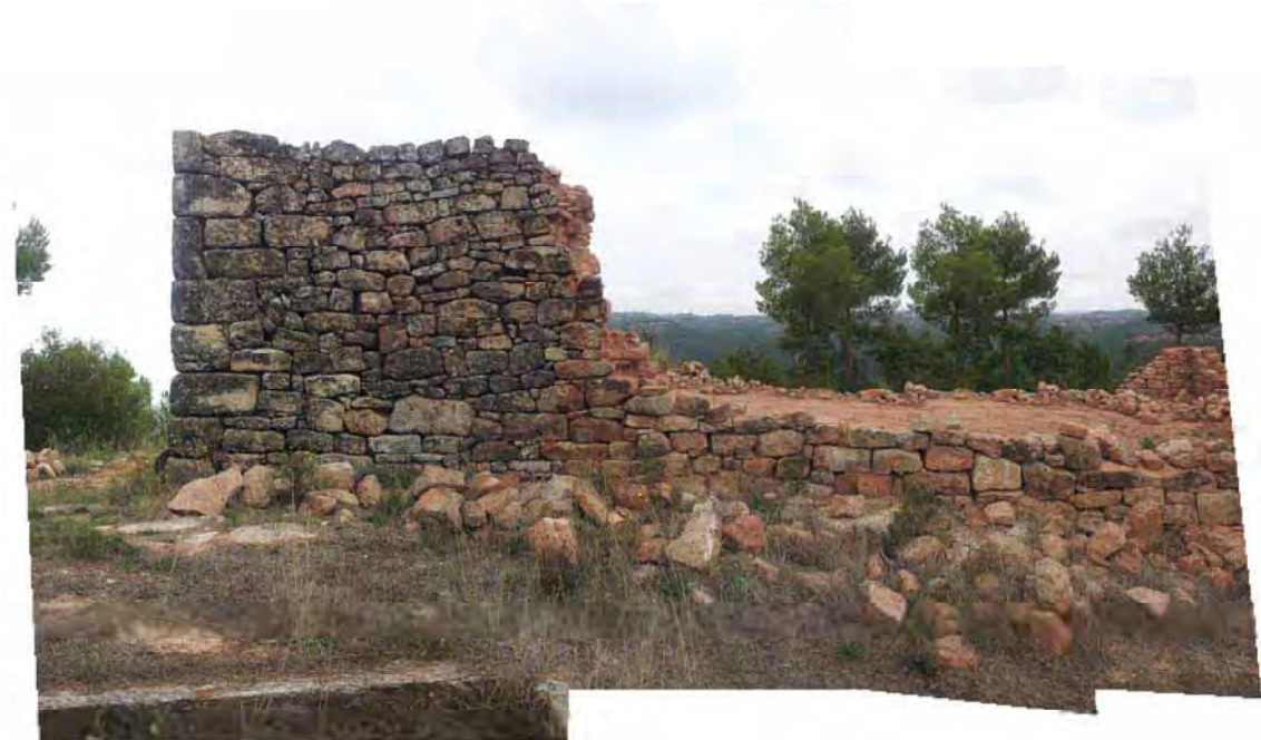
Façana Sud Est – Àmbit superior al camí
