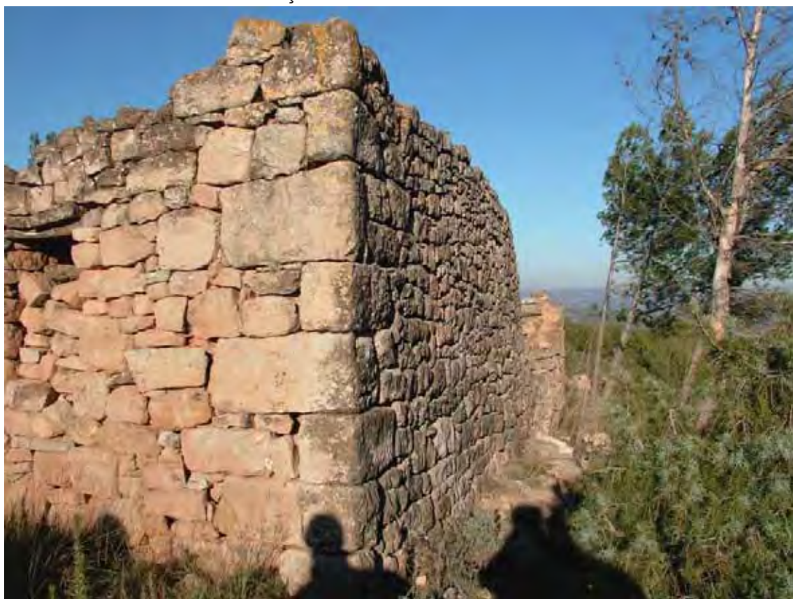
Façanes Sud Est i Nord Est
