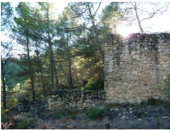
Les construccions de la part més est són més baixes
