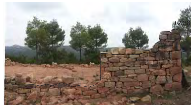
Façana Sud Est a mantenir
