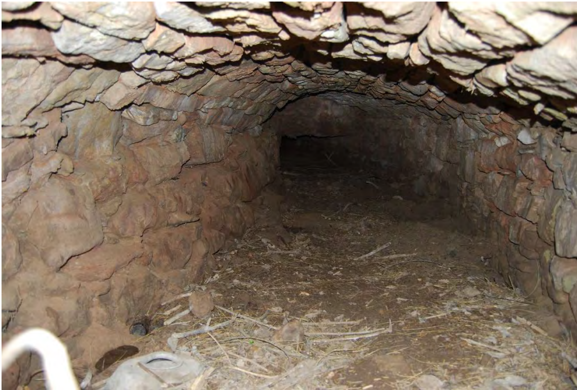
Interior de l'estructura de desguàs.
