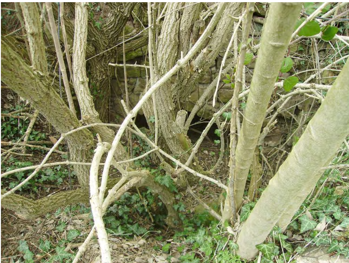
Obertura de desguàs de l'edifici principal. Actualment es troba soterrada per la terra acumulada, que es va dipositar en aquest sector, provinent de l'actual hort.
