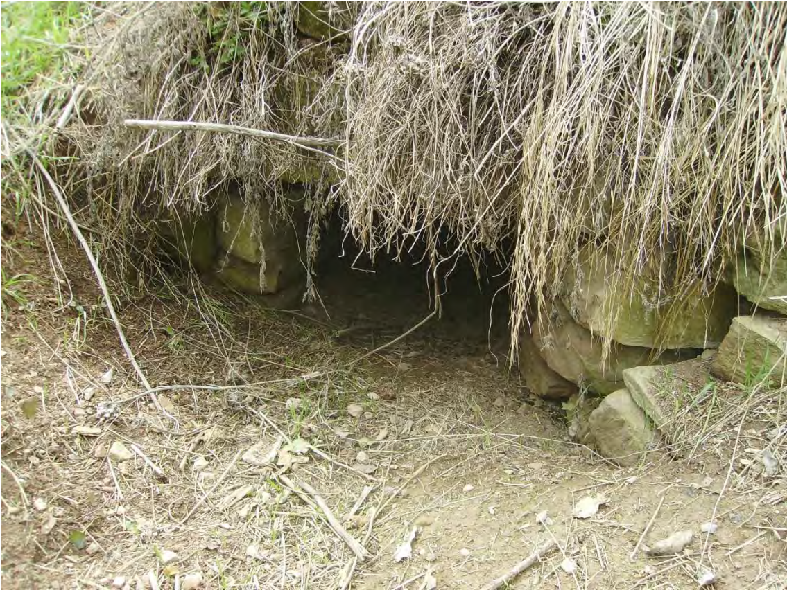
Obertura de desguàs ubicada un 20 metres a l'oest de l'edifici principal, i que dona a un barranc que connecta amb el riu Anoia.
