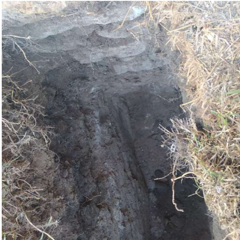
Fotografia 16. Caja d'inspecció nivell de fonamentació de paret existent
