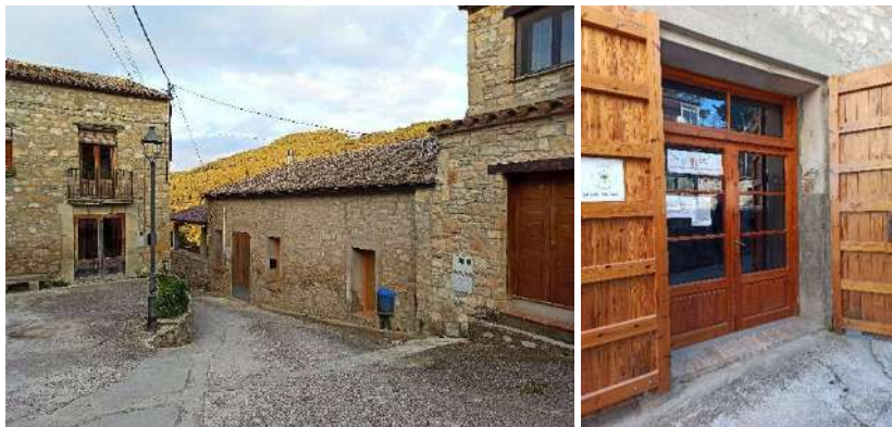
Fotografia 4. Façana nord del Casal i porta d'accés. Font: Pròpia
