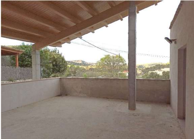
Fotografia 14. Cantonada façanes nord i est (vista interior)
