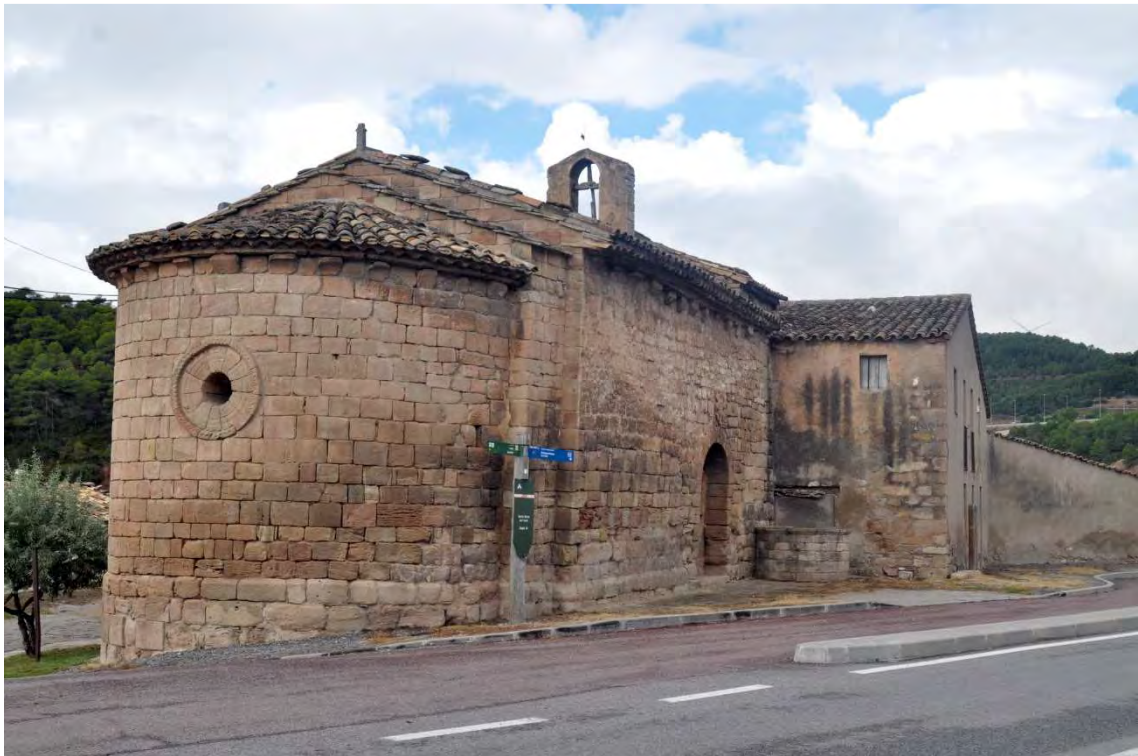
Vista de la façana nord
