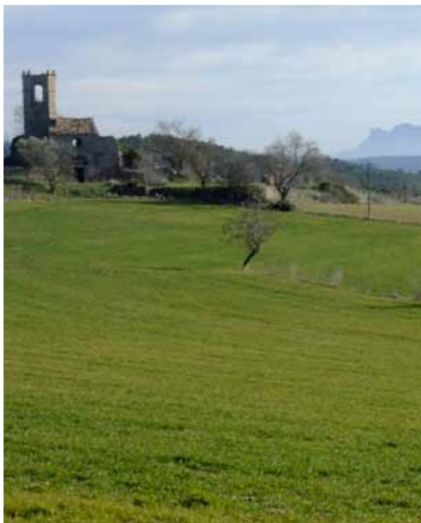
Les runes de l'església d'Albarells amb Montserrat al fons, són un bon exemple d'un patrimoni que es perd i que podria conservar-se.
